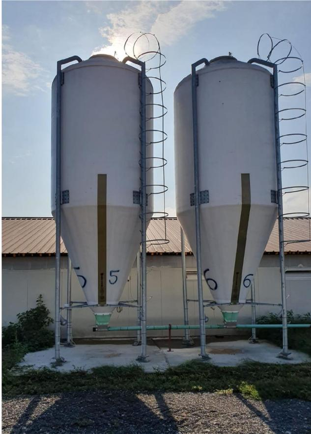
*Figura 3.* La figura mostra due sili contenenti il mangime, collegati alla linea di distribuzione dell'alimento.
